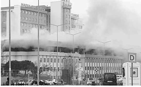
MANİSA Celal Bayar Üniversitesi Hıfza Sultan Hastanesinin çatı bölümündeki atık malzemelerin tutuşması sonucu çıkan yangın itfaiye ekipleri tarafından söndürüldü.
